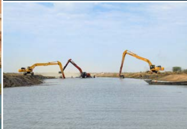
Reabilitação e obras de construção nos adutores do Alto Delta – Lotes 1 e 2
